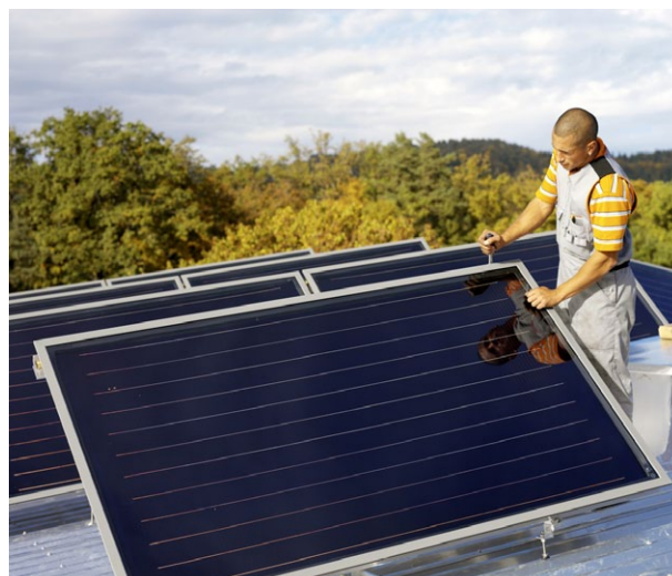
Kollektormontage am Flachdach
