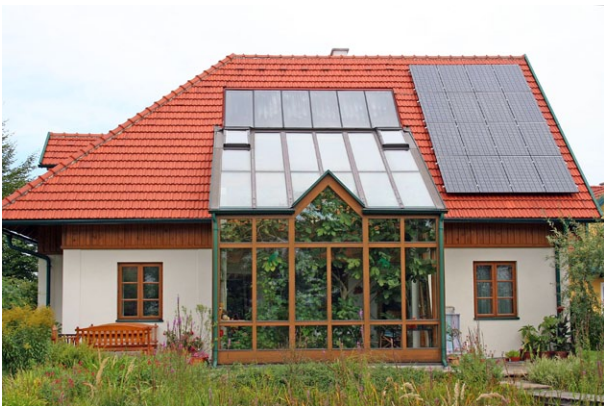
Sonnenkollektoren (oberhalb des Wintergartens) und Photovoltaikmodule (rechts davon)
